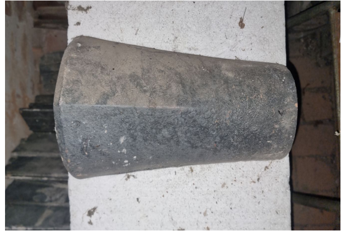
Istniejący wzór gąsiora dachowego
