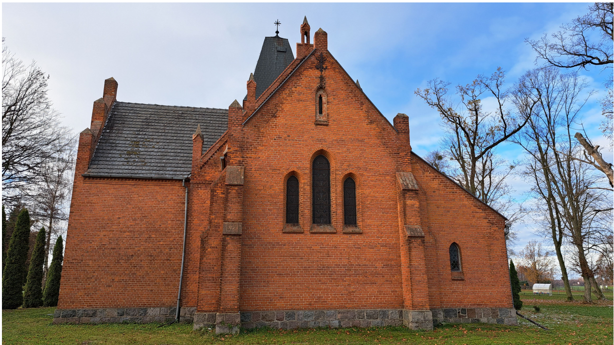
Fot. Elewacja wschodnia
