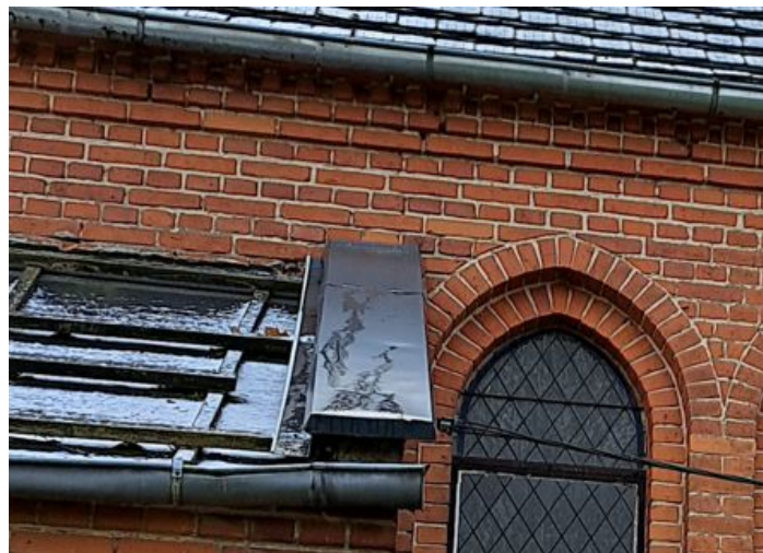
Ze względów konserwatorskich brak możliwości opierzeń górnych attyk
