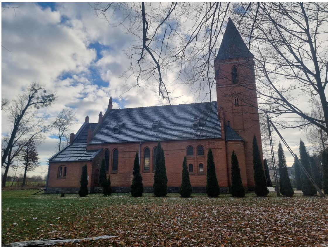
Fot. Elewacja północna
