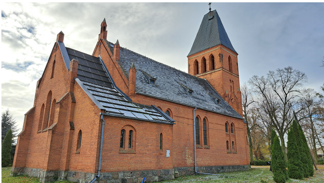
Fot. Elewacja północno-wschodnia
