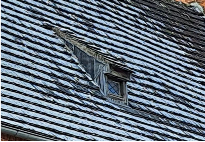
Istniejące lukarny do naprawy i wyłożenia ścian bocznych blachą
